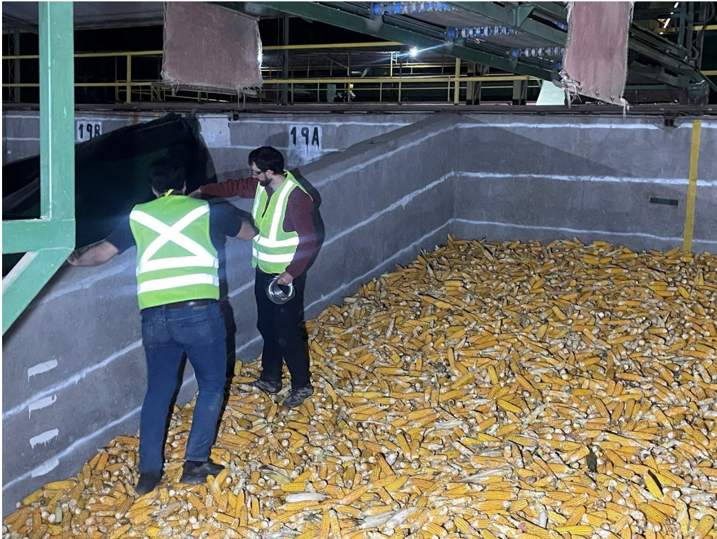
Instalación de sensores sobre el lecho
