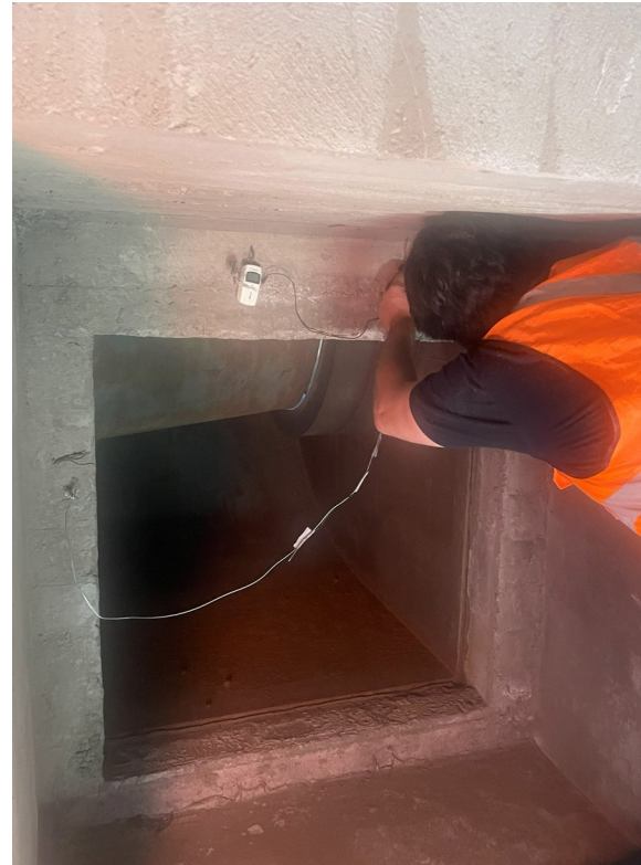
Sensor en la entrada de aire a la cámara
